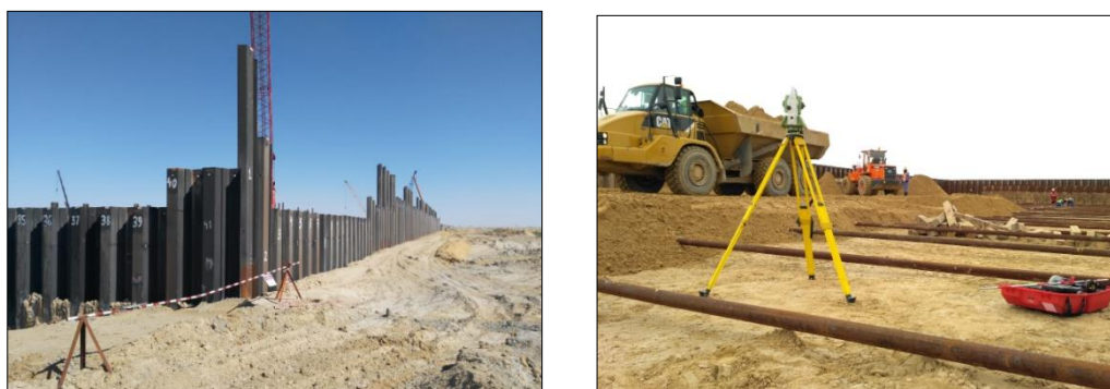
Рисунок 4 – а) процесс забивки свай и б) процесс засыпки песком пространства между шпунтовыми стенами
